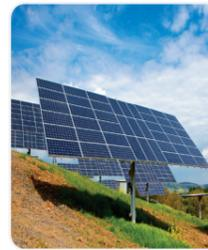
Automatisches Zurücksetzen auf die Sonnenaufgangsposition über Nacht.
